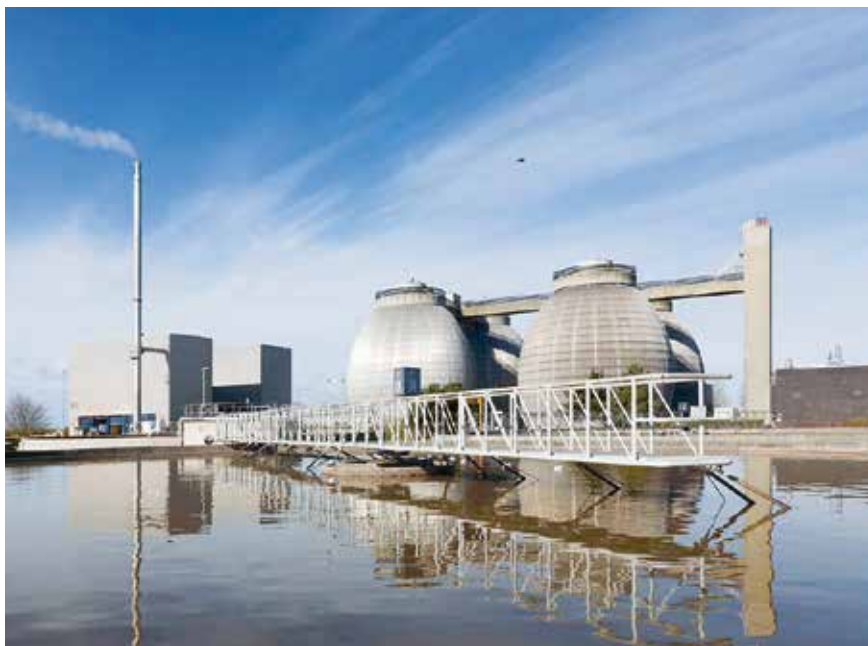
BIOFOS renseanlæg Avedøre. Foto: HVIIDPHOTOGRAPHY/BIOFOS
